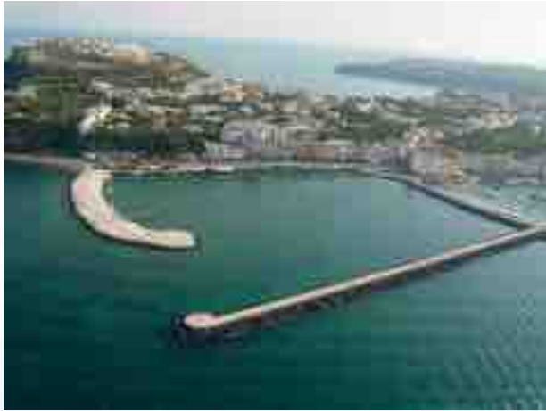
Il porto di Procida prima dei lavori
